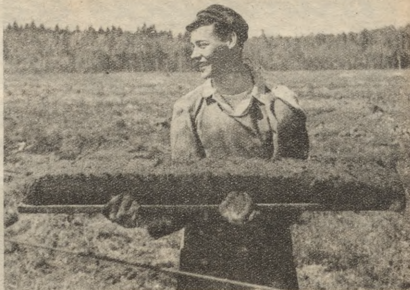
Mašīnā sapresētos kūdras ķieģelīšus slīdošās stieplu lentes aiznes klājlaukumos. Te vajadzīgas veikas rokas, kas dēlīšus ar kūdru laikā noņem.
